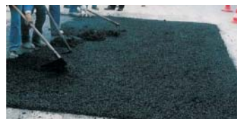
Remplir avec RESI'SOLDUR Etaler à l'aide d'un rateau
