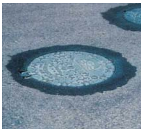
Nettoyer éventuellement le trou à combler
