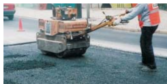
Compacter (dame ou plaque vibrante ou rouleau compresseur)
