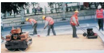
Décrouter, éventuellement Nettoyer & compacter la surface
